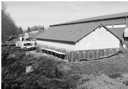
Nadzemní objekt před provedením terénních úprav
